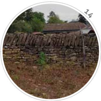
Le mur de clôture, dressé face à une ancienne carrière, a été réalisé avec des pierres calibrées et taillées.
