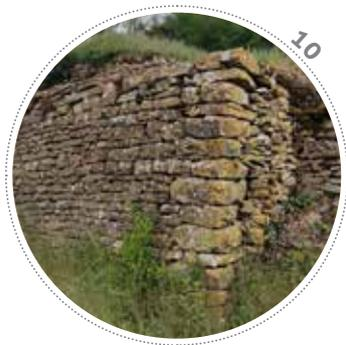
Cet angle chaîné marque le départ d'une rampe d'accès aux vignes. On constate un soin porté dans la mise en œuvre du parement principal, en comparaison du parement sur la parcelle, bien plus rustique.
