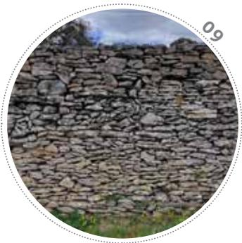
Par son emplacement dans la pente, ce mur agit tantôt comme un mur de séparation, tantôt comme un mur de soutènement. Sa mise en œuvre désordonnée témoigne d'une succession d'interventions, appelant différents types de pierres.
