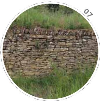
Ce mur de soutènement a été érigé à proximité d'une ancienne carrière. Il soutient un chemin devenu route carrossable. Sa mise en œuvre est soignée, il est coiffé d'un couronnement en hérisson. Sa mise en œuvre est semblable à certains murs de clôture à proximité (14).
