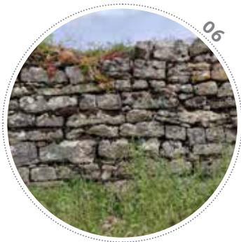
Ce mur de soutènement présente un appareillage de pierres soigneusement dressées, posées en assises régulières.
